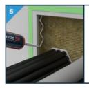
Kleben Sie die Multimastic-FB Brandschutzplatte mit Multimastic-SP-Spachtelmasse in die Konstruktion und verleimen Sie es mit den Durchführungen.
