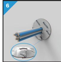
Bringen Sie die Multidisc sorgfältig an und stellen Sie sicher, dass die Schließseite eine Überlappung hat. Drücken Sie die Multidisc gut an der Konstruktion und rund um die Durchführung an!
