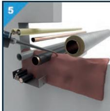
5 Füllen Sie die Öffnung von hinten nach vorne und bauen Sie den Schaum von unten nach oben auf. Halten Sie das Ende des Mischeraufsatzes über dem Schaum, so dass dieser nicht verstopft<sup>1)</sup>.
